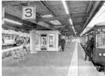
※ 能勢電鉄山下駅。妙見口駅方面に行くには左端の1号線ホームから3号線ホームへの乗り換えが必要になった＝兵庫県川西市
